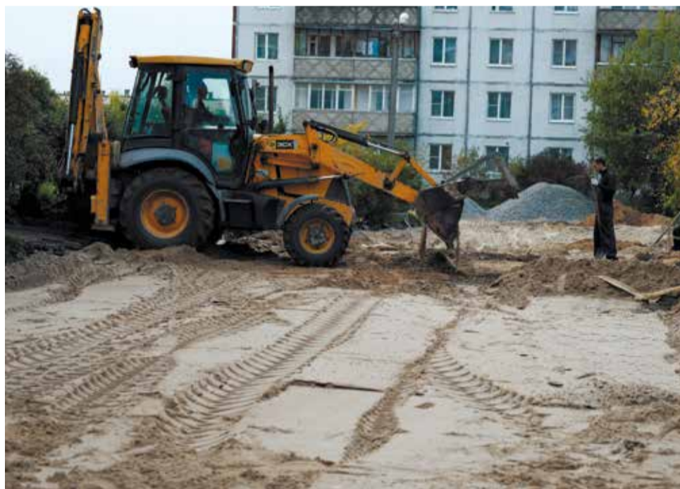
Ремонт дворовой территории дома 209 по Советскому проспекту
